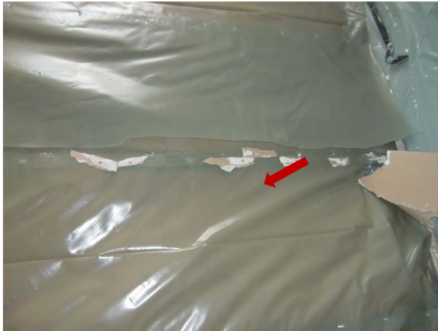
Kein luftdichter Anschluss Dampfbremse am Mauerwerk im Dachgeschoss
