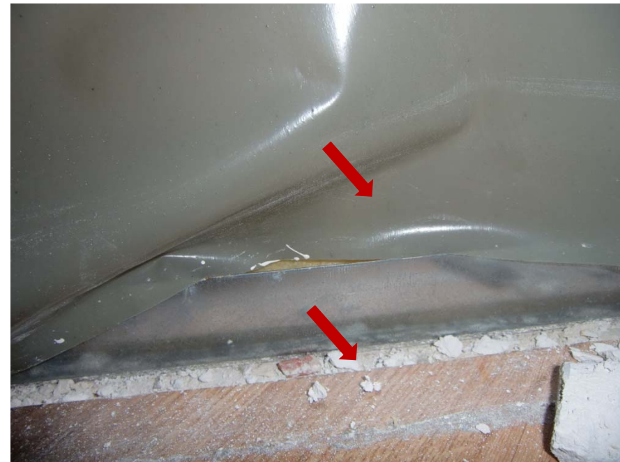
Kein luftdichter Anschluss Dampfbremse am Mauerwerk im Dachgeschoss
