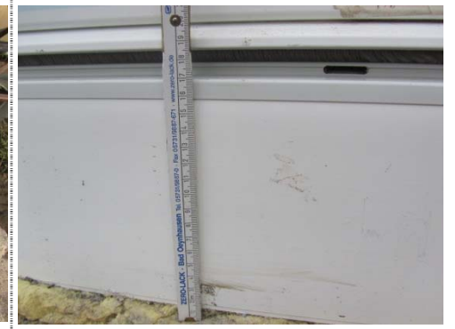
Lieferung 2 weiße Kunststoffbeschichtung und Blendrahmenverbreiterung
