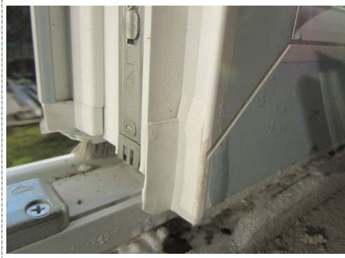
angeklebte Dichtungslippe
