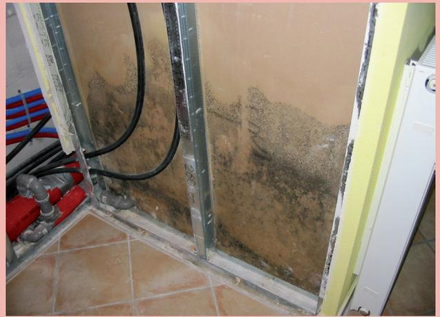
Diese Gipskartonwand ist flächig von Schimmel befallen. Angesiedelt hat sich *Stachybotrys chartarum*, ein humanpathogener Schimmelpilz, der die Gesundheit der Bewohner stark gefährdet. Ursache dafür ist ein Wasserschaden an der Dusche. Hier hilft nur eine Komplettsanierung.
