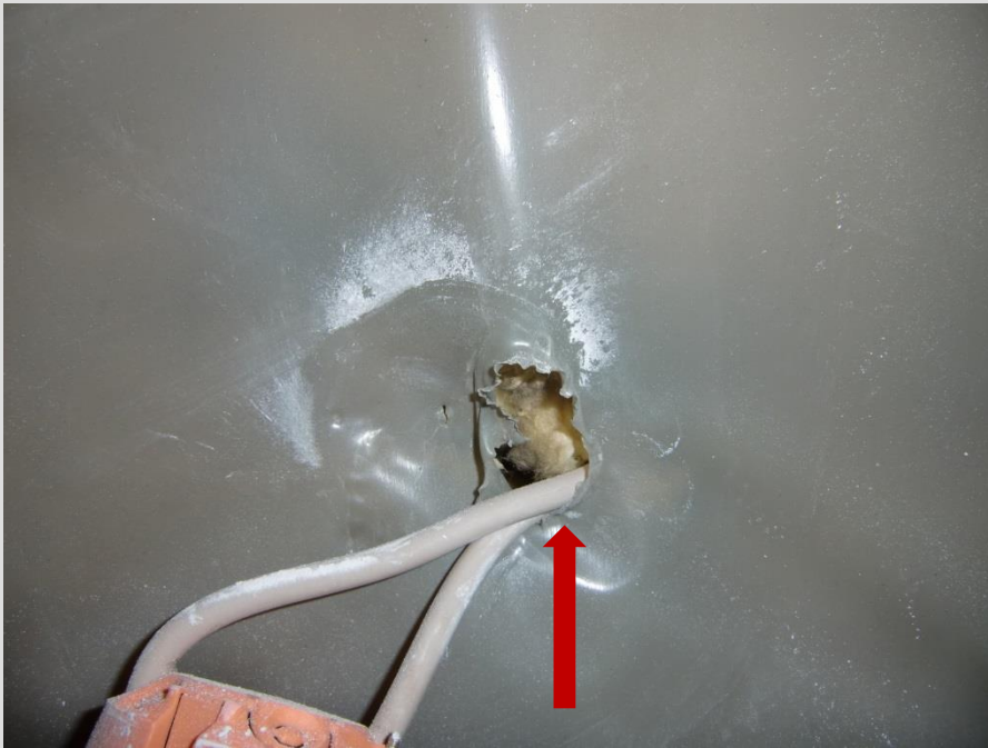
Kabeldurchdringung unverschlossen
