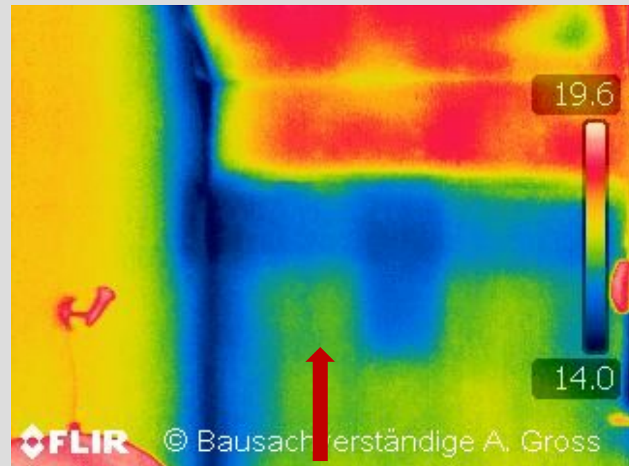
Wärmebrücke an Drepel: Ringanker aus Beton sichtbar
