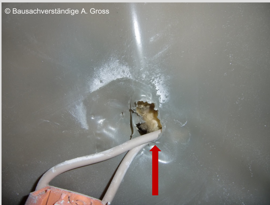
Kabeldurchdringung unverschlossen
